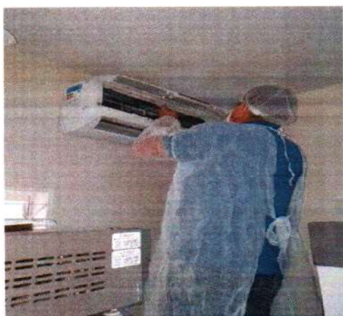
Figura 1 . Manutenção Ar condicionado
